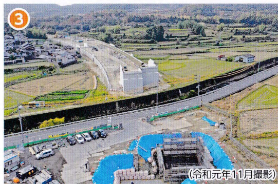
168号跨道橋の奈良側の本線部橋台工事に着手しました。
