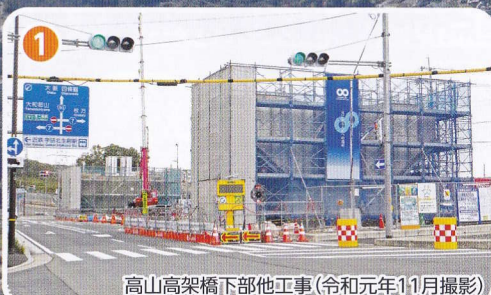
高山高架橋下部他工事(令和元年11月撮影)
