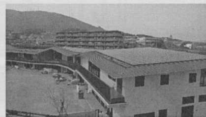
南こども園 太陽光発電 (市民エネルギー 生駒保有)
