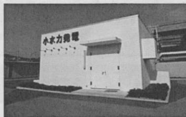
山崎浄水場 小水力発電 (生駒市保有)
